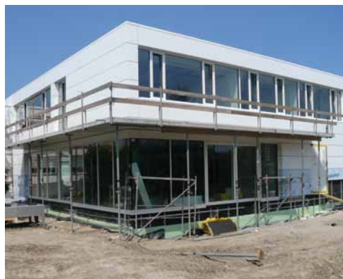
Dritter Erweiterungsbau des KRZ-SWD Quelle: Geis & Brantner, Freie Architekten BDA
