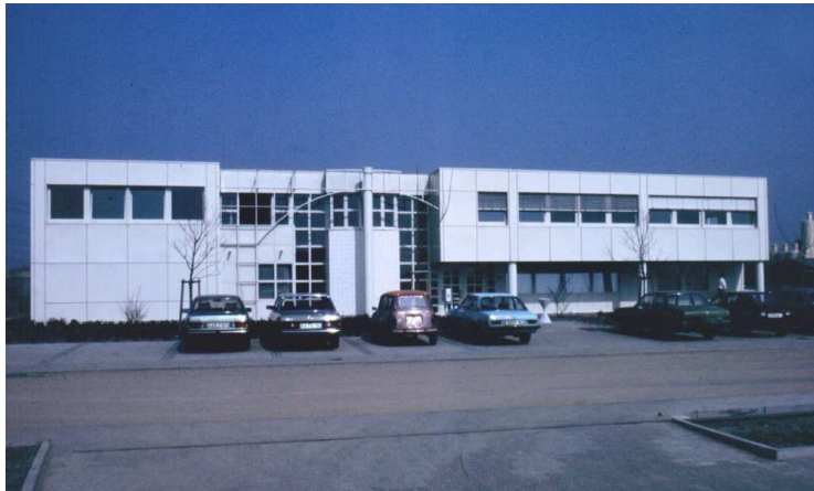
Bau A und B
