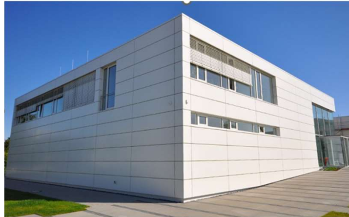
Bau C mit neuem Rechnerraum
